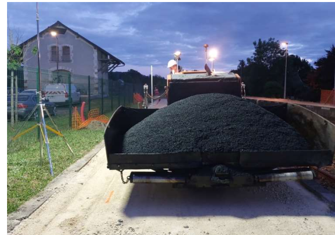
Réfection des enrobés à Razac
