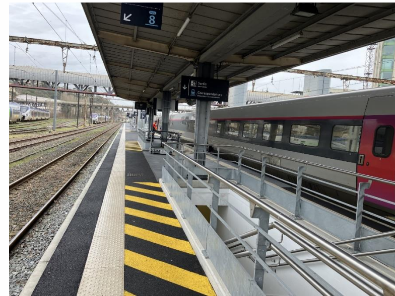
Rehaussement des quais en gare de Poitiers
