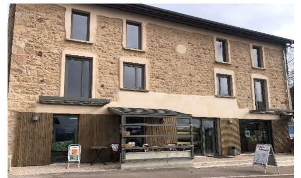
Nota : photo prise en mars 2023. Travaux en cours (garde-corps)
