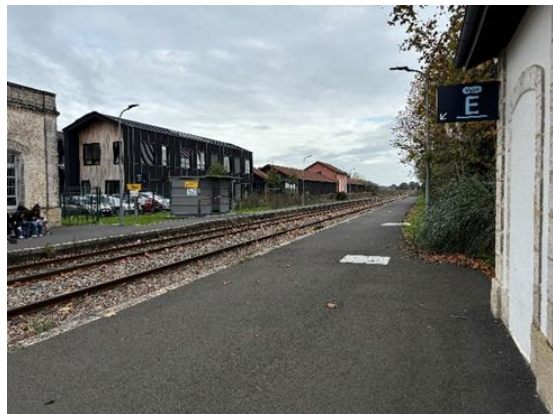
Rénovation des quais
