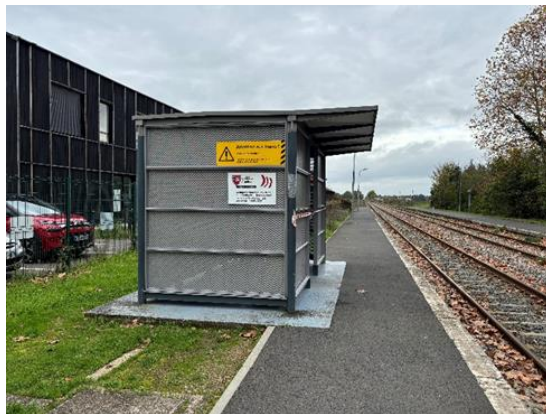
Rénovation des abris voyageurs
