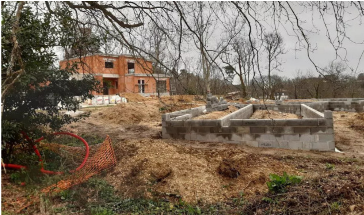
Lotissement en cours de construction à Bouliac (SB/Rue89 Bordeaux)
