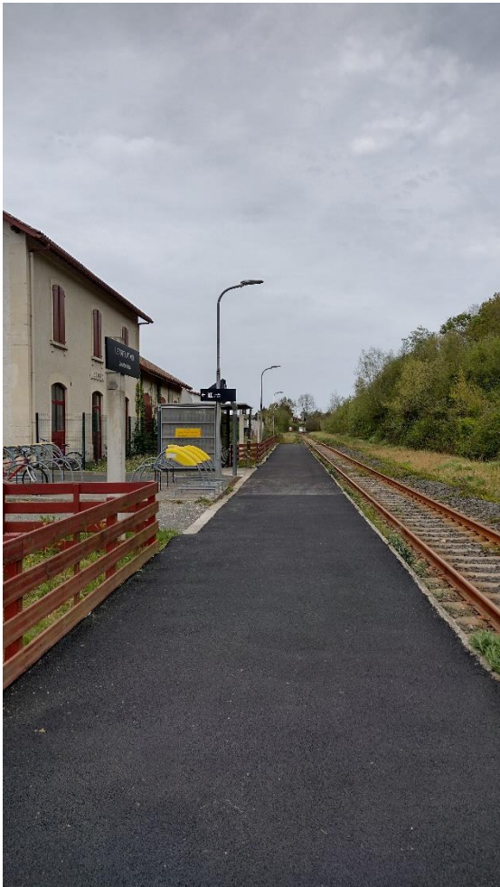
Rénovation du quai de la halte d’Ustaritz-Jatxou
