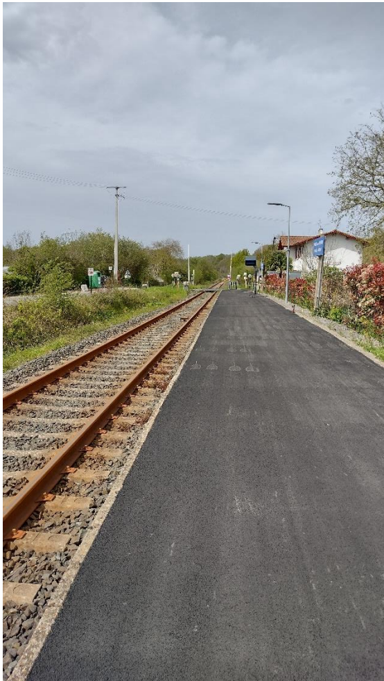
Rénovation du quai de la halte de Halsou-Larressorre
