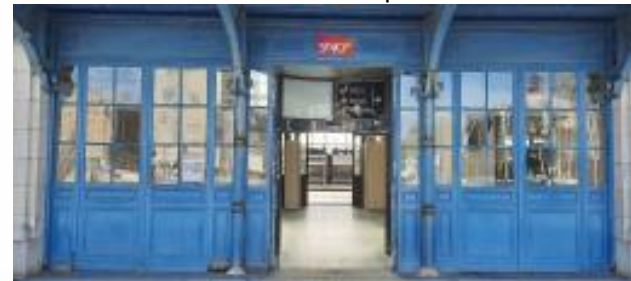
La Rochelle – Portes automatiques
