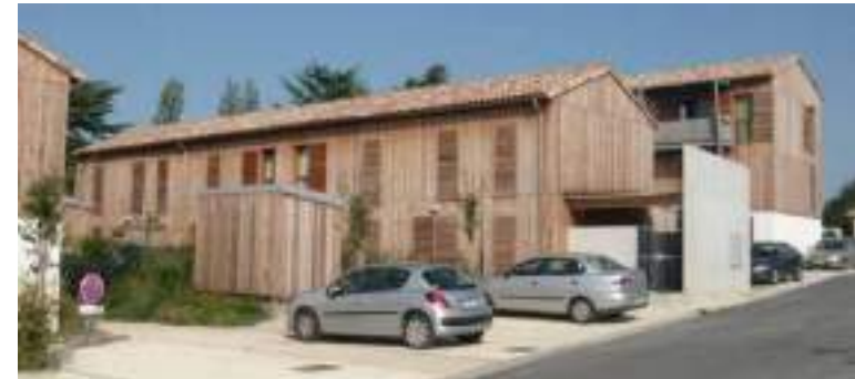
30 logements groupés et superposés à basse consommation d'énergie : volonté de donner une image de longère – Label HQE et Label BBC / Effinergie - coût total 1180 €/m 2 (Montamisé, 86 - Source : http://www.prixnational-boisconstruction.org )
