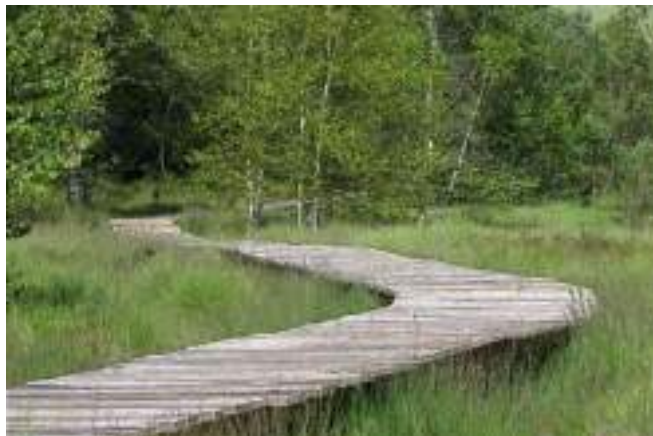
Tourbière de Négarioux Malsagne : platelage en douglas – entreprise locale et bois limousin (Peyrelevade, 19 – source : Ambiance Bois)
