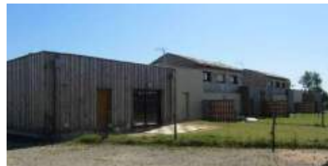
Maisons en bande : 10 logements sociaux T3 et T4 ; alternance bois et maçonnerie – coût total 1130 €/m 2 (Pompaire, 79 - Source : http://www.prixnational-boisconstruction.org )
