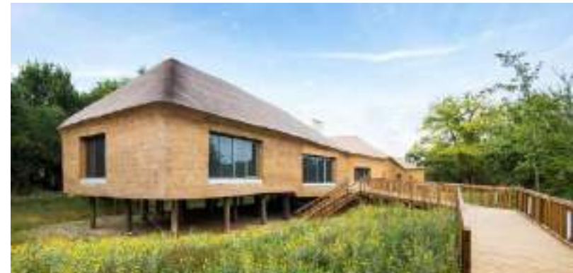
Centre de découverte, de culture scientifique et de recherche sur l'environnement et la biodiversité (La Roche-sur-Yon, 85 - Source : http://www.prixnational-boisconstruction.org )
