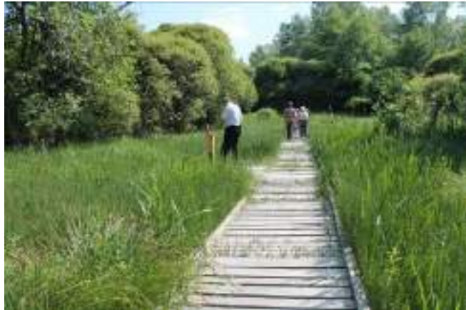
Sentier de découverte du Marais du Brézou : platelage flottant en châtaignier – entreprise locale. (Lagraulière, 19)
