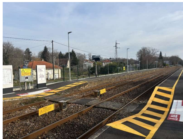
Halte de Saint-Léon-sur-l'Isle : remise en état des quais et signalétique de sécurité de passage piétonnier, rénovation de l'éclairage
