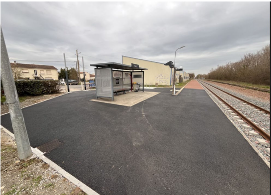
Fors - aménagement abri et quai
