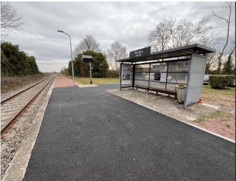
Marigny - aménagement abri et quai
