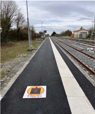
Beauvoir-sur-Niort réfection totale des deux quais
