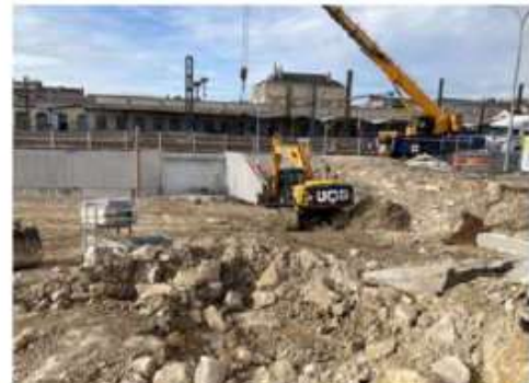
Niort – création du parvis est et du mur de soutènement.
