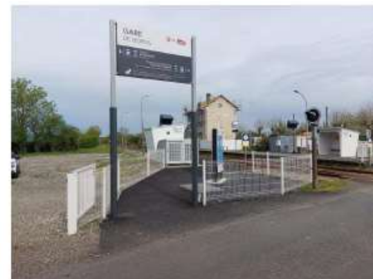
Bords – Sécurisation des accès
