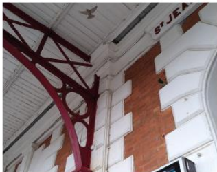
Pannes: Traces de corrosion / Sous-face en lambris bois: état sanitaire correct
