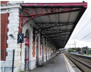
Photo générale de la marquise - côté quai
