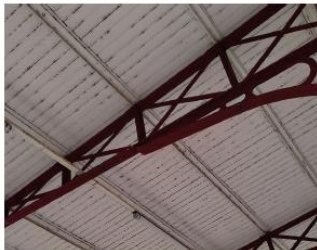
Pannes: Traces de corrosion / Sous-face en lambris bois: état sanitaire correct
