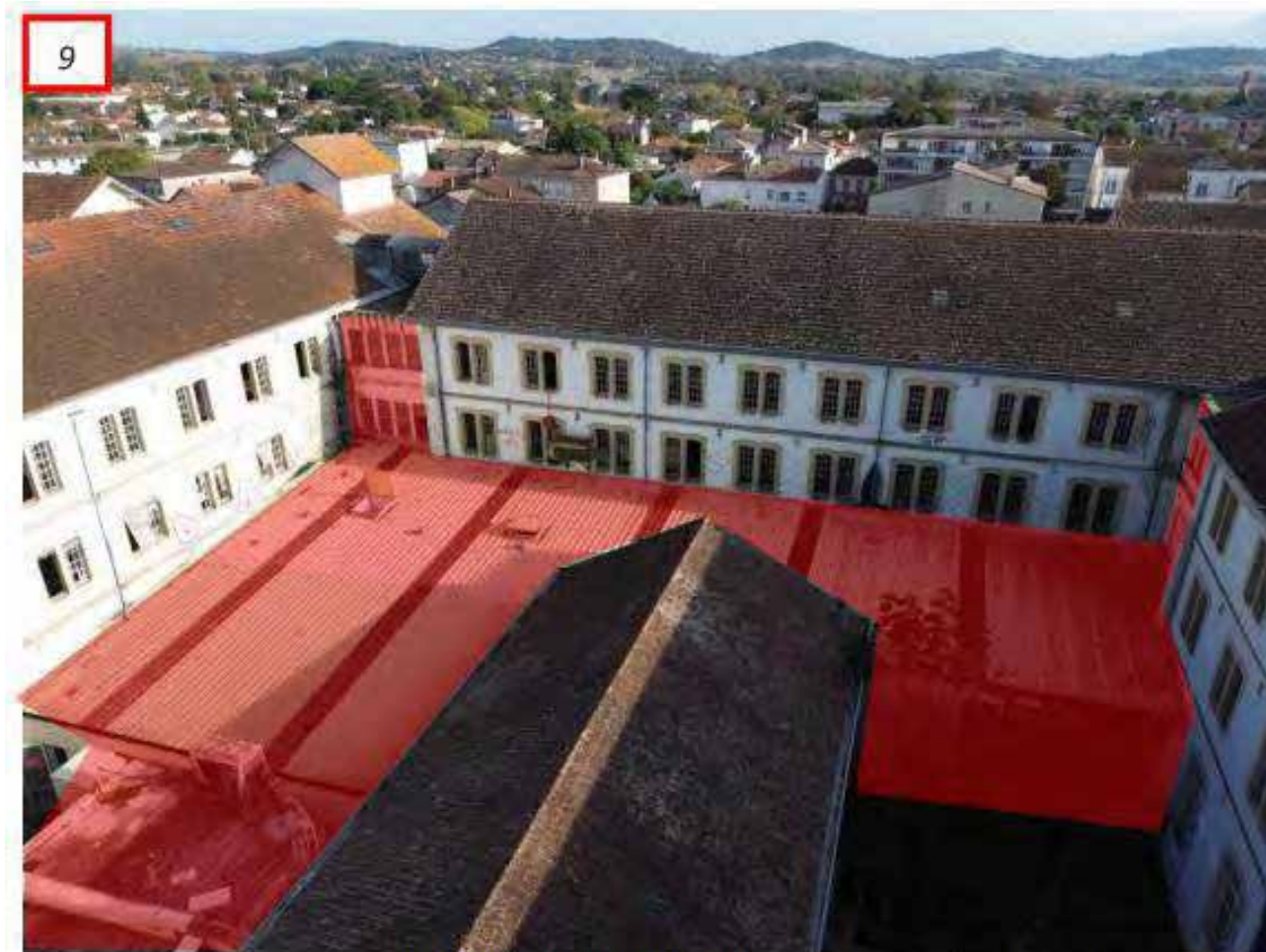
Déconstruction bâtiment K', Hexagones et extensions
