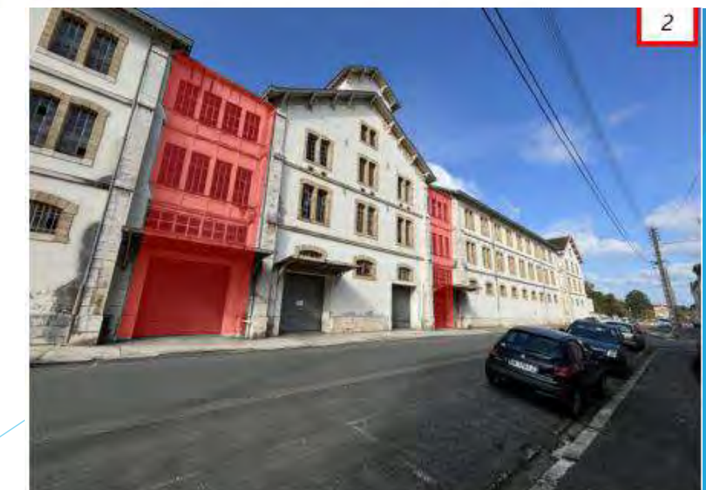
Passages traversants entièrement déconstruits
